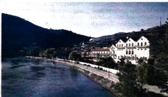
O Vintage House Hotel tem no seu interior uma academia de vinhos
